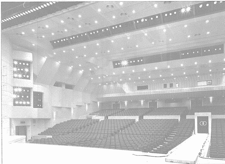
●シーリングとサイドフロントライト
