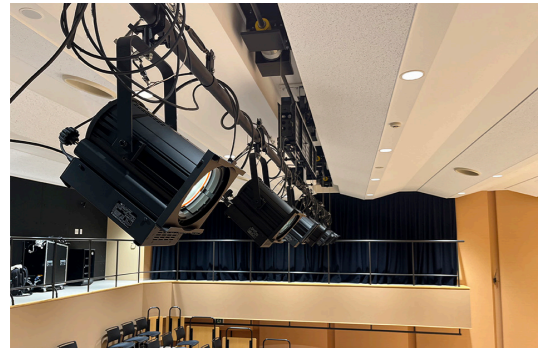
シーリングライトに設置されたLEDスポットライト LSC2-605-WW
