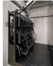
フロア回路用移動型調光器
