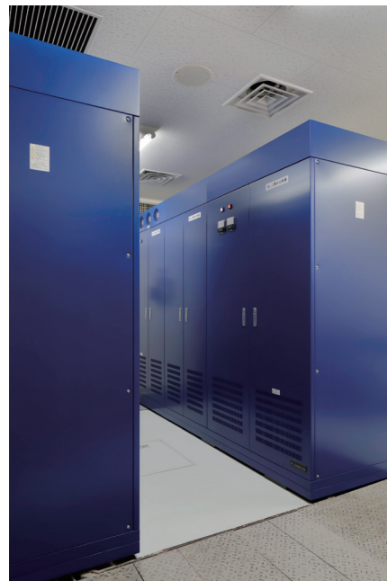
調光主幹盤・分岐盤
