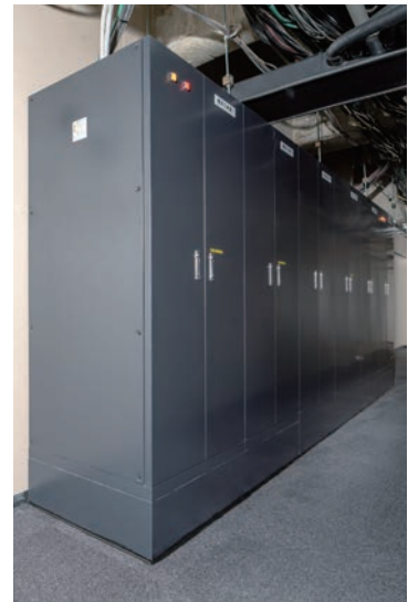
客席上部電源盤 (客席サスペンションライト・バルコニーライト・シーリングライト用)
