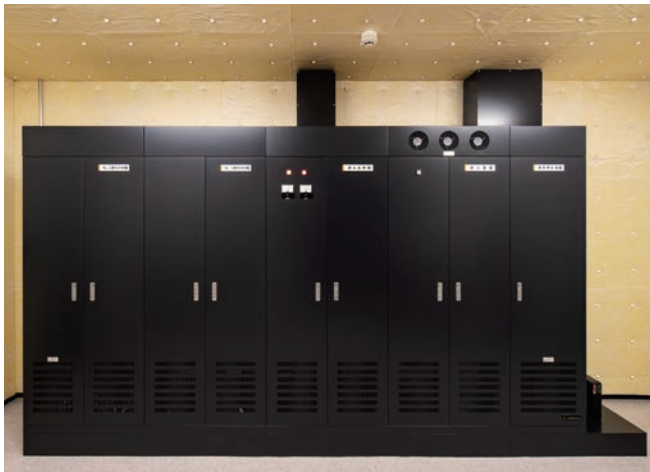
調光主幹盤・分岐盤
