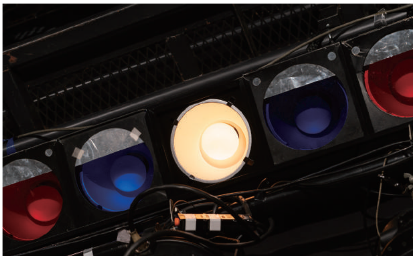
特別仕様の白熱型ハロゲン電球を光源に採用したボーダーライト
