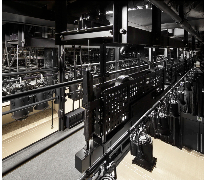
ホール天井部のキャットウォーク
