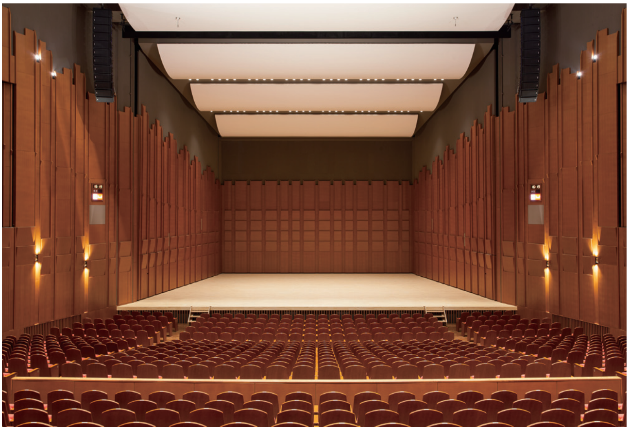
音響反射板を設置した舞台
