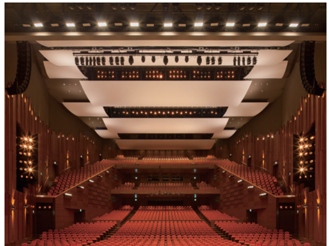
第 1 ボーダーライトに設備された LED フラッドライト
