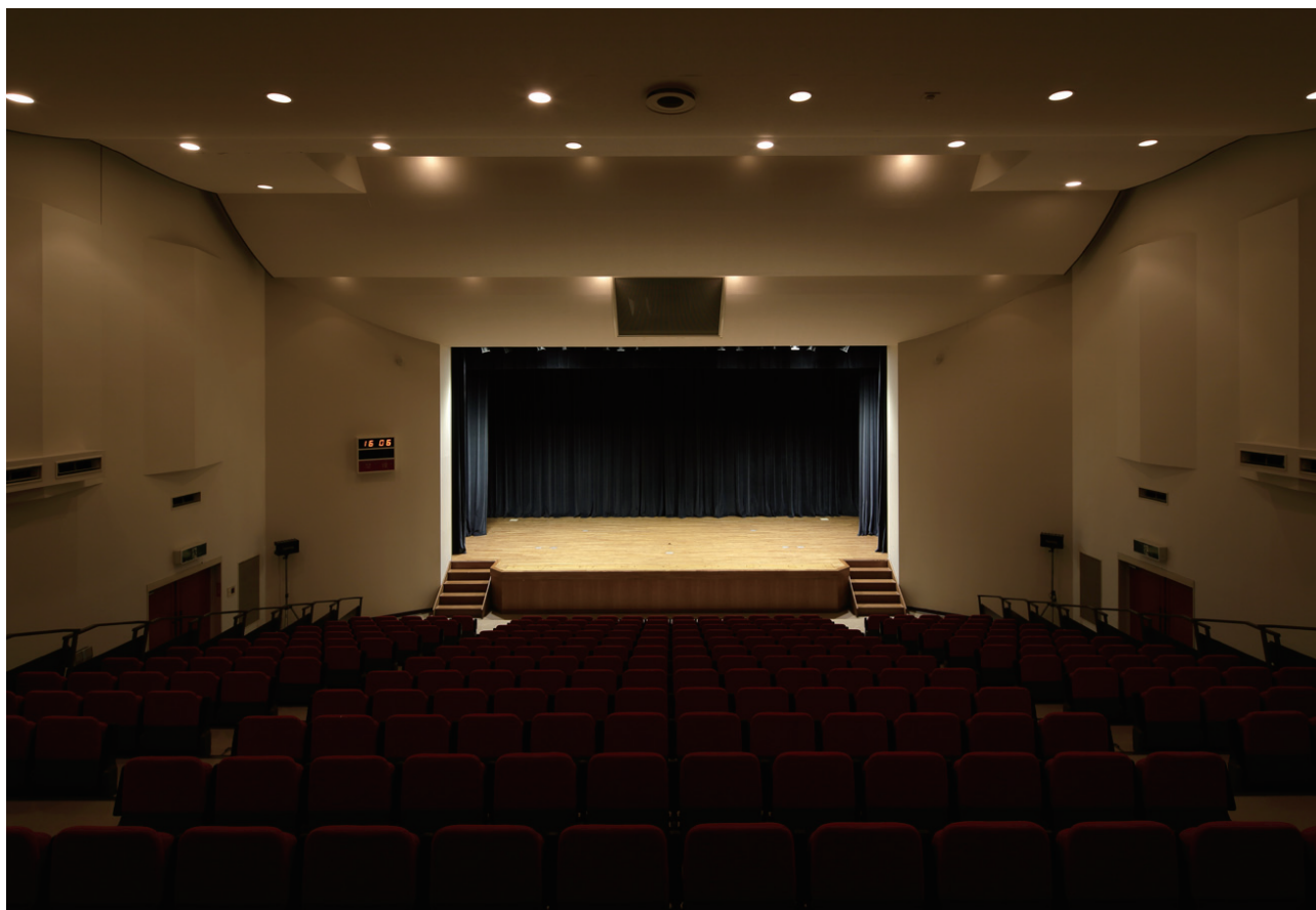
ボーダーライトとして設置されたLEDフラッドライトだけを点灯した舞台
