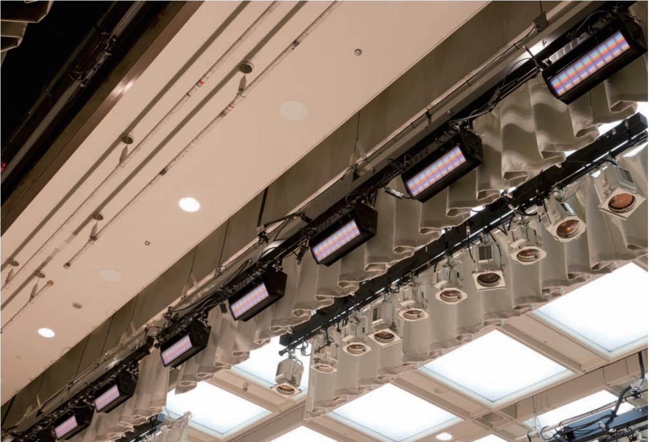
アッパー・ホリゾントライトとして設置されたLEDフラッドライトLEF型6MUH-6CB
