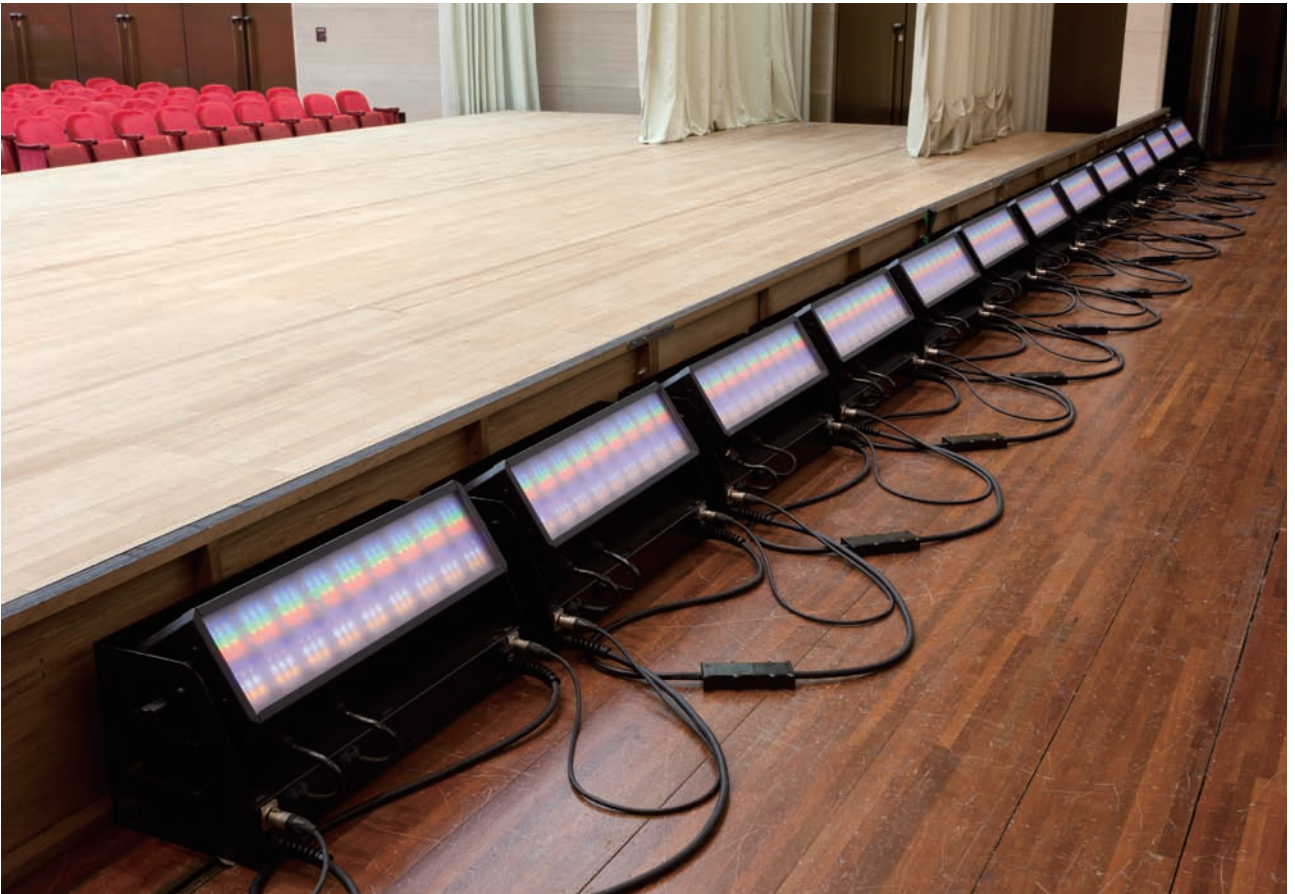
ローア・ホリゾントライトとして設置されたLEDフラッドライトLEF型6MH-6CB
