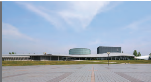
長岡リリックホール外観
