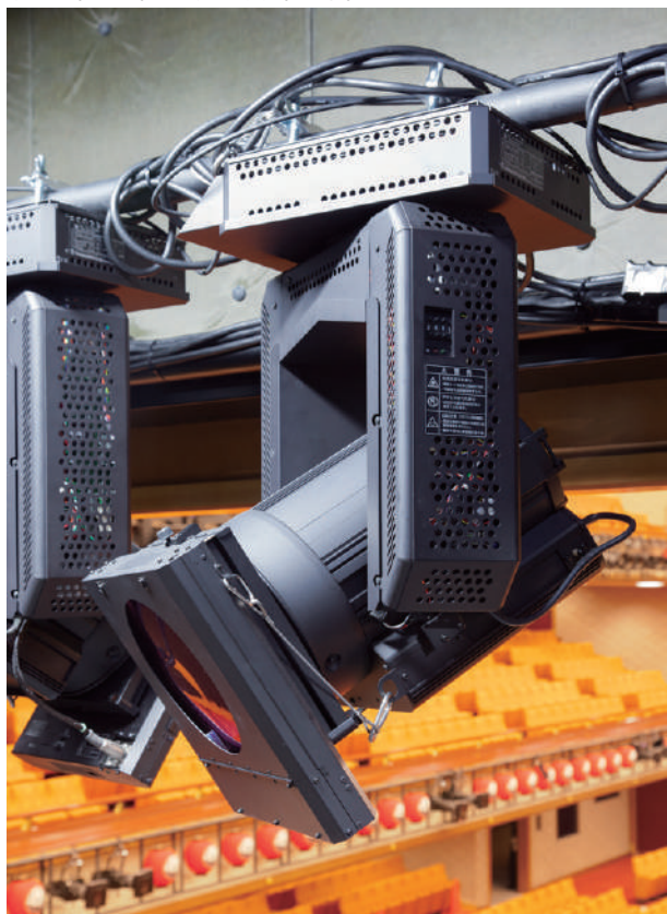
上手フロントサイド室には、花道用フォローのためのソフトピンスポットライトや前明かり用としてリモートコントロールスポットライトが備えています。
