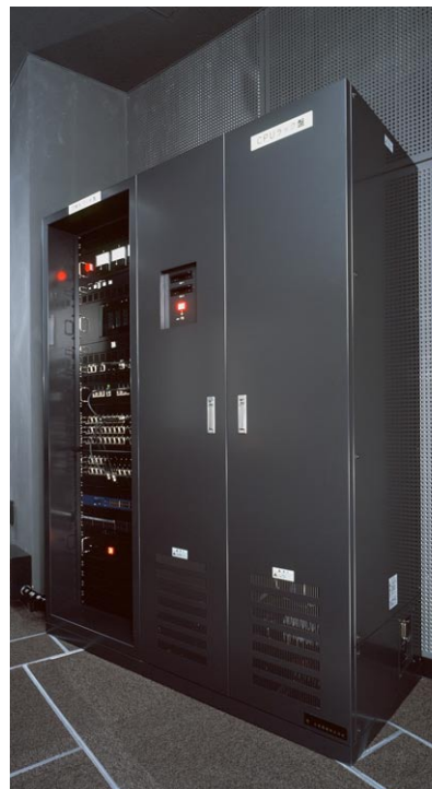
小ホール DMX パッチ盤 CPU ラック盤
