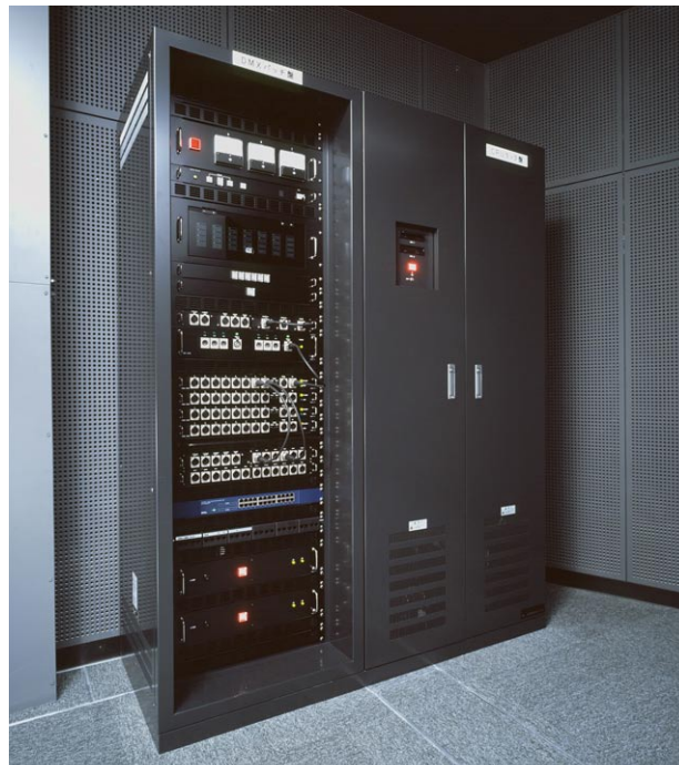
大ホール DMX パッチ盤 CPU ラック盤
