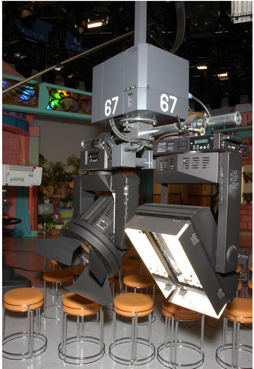
一点吊りバトンに設備されたリモコンスポットライト (左) と蛍光灯リモコンフラッドライト (右)
