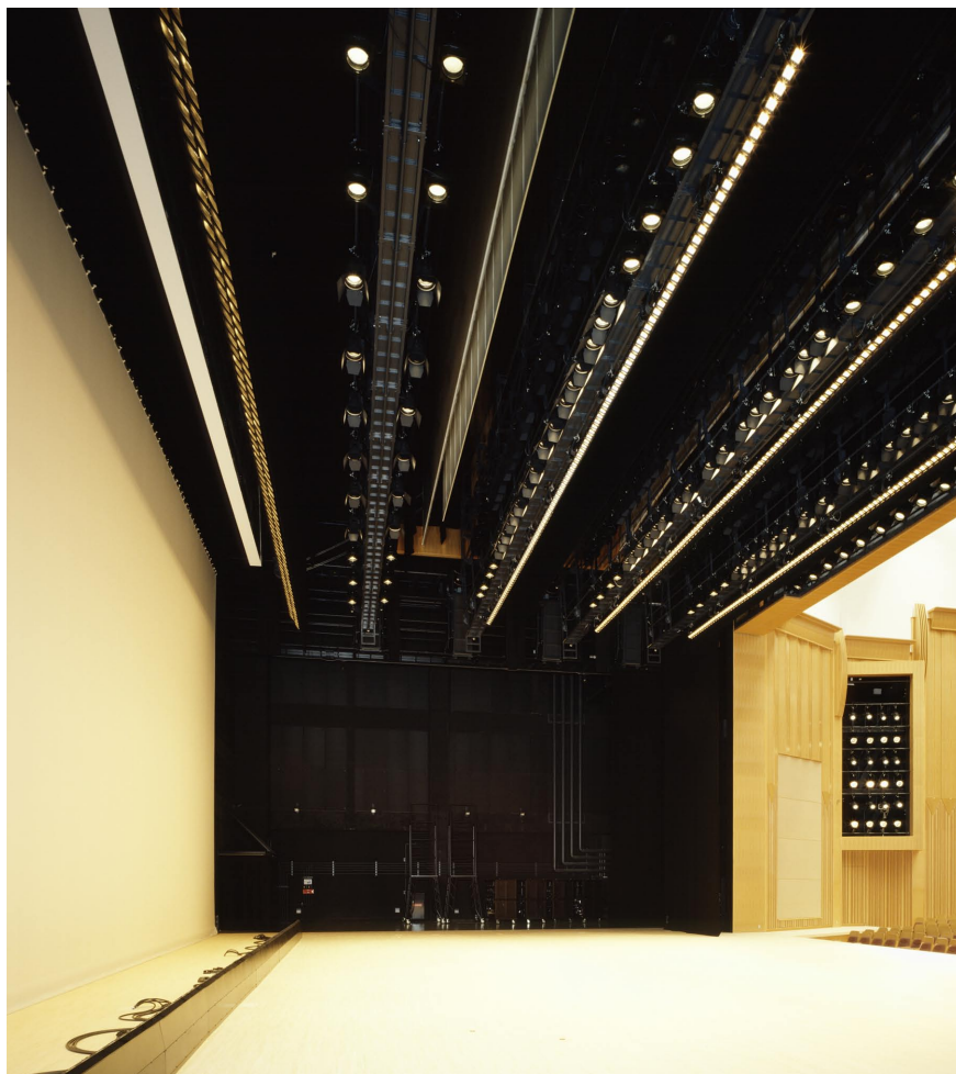
大ホール [きりしま] 舞台上部
