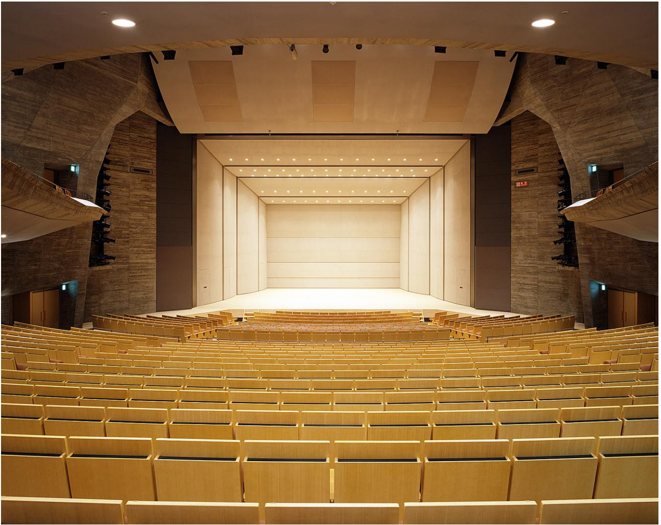
大ホール 音響反射板を設置した舞台
