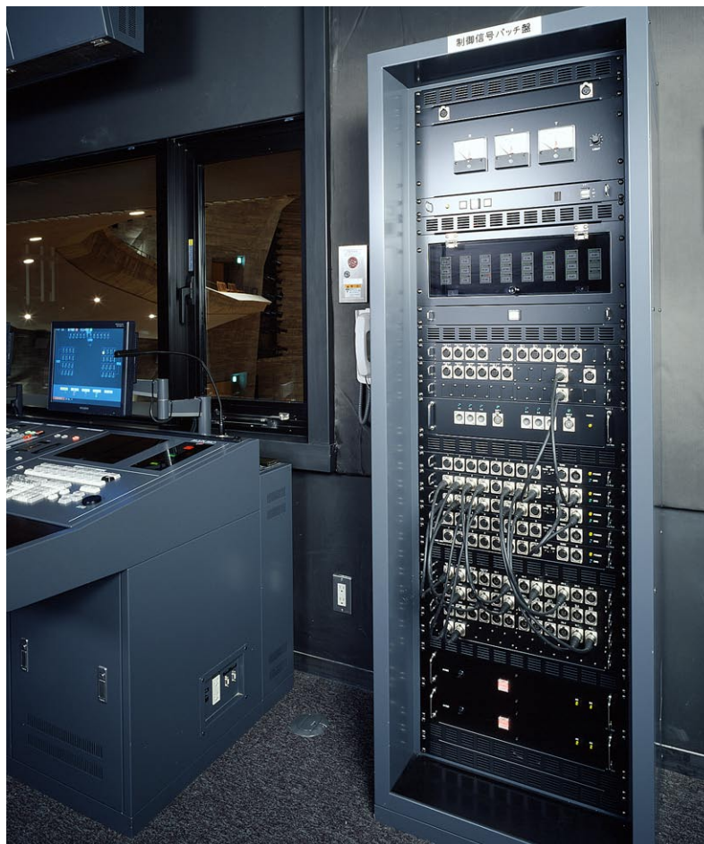
大ホール調光操作室 制御信号パッチ盤
