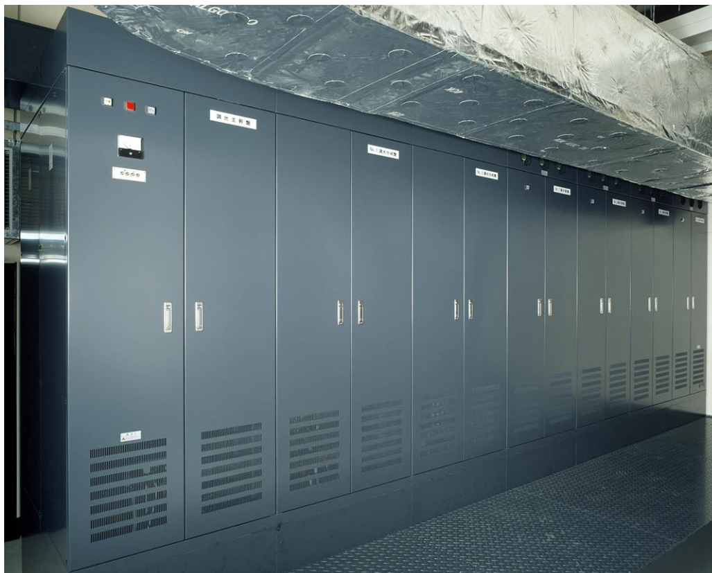
大ホール調光操作室 制御信号パッチ盤
