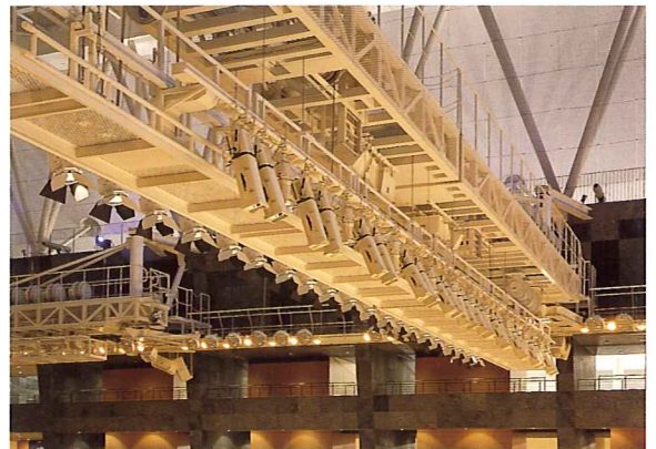
ライトブリッジに設備されたRJ611SXカッタースポットライト
