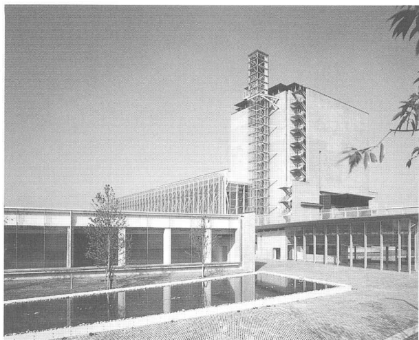
熊谷文化創造館外観
