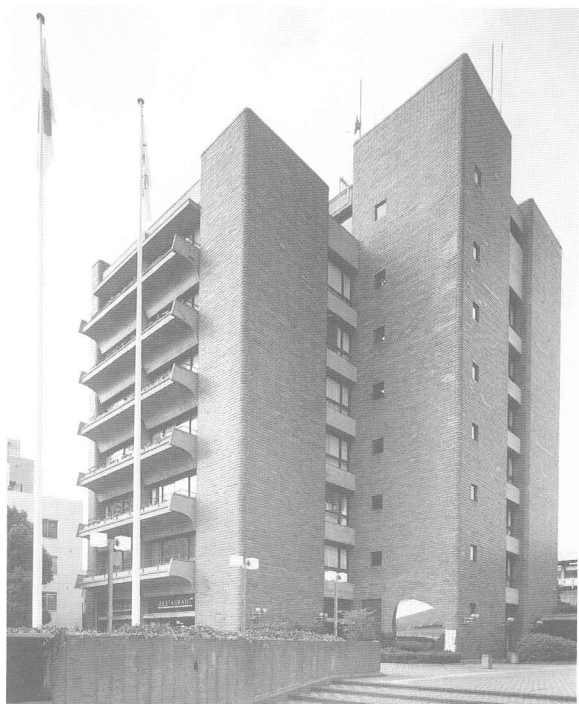
埼玉会館外観
