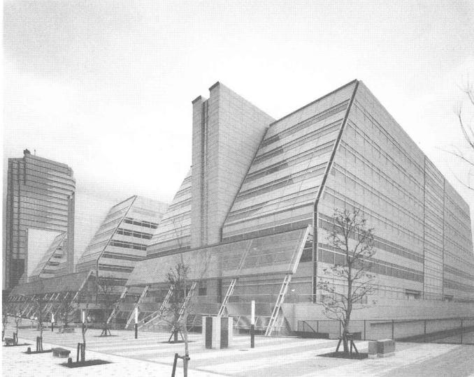
TFTビル外観
