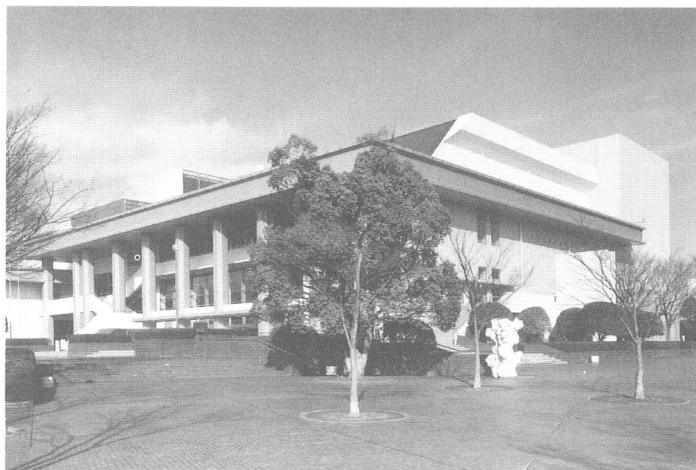
静岡市民文化会館外観
