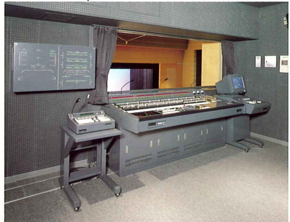
小ホール(星のホール)調光室
