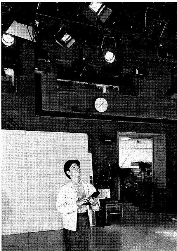
▲ワイヤレスコントローラを使ってのムービングスポットライトの制御操作
