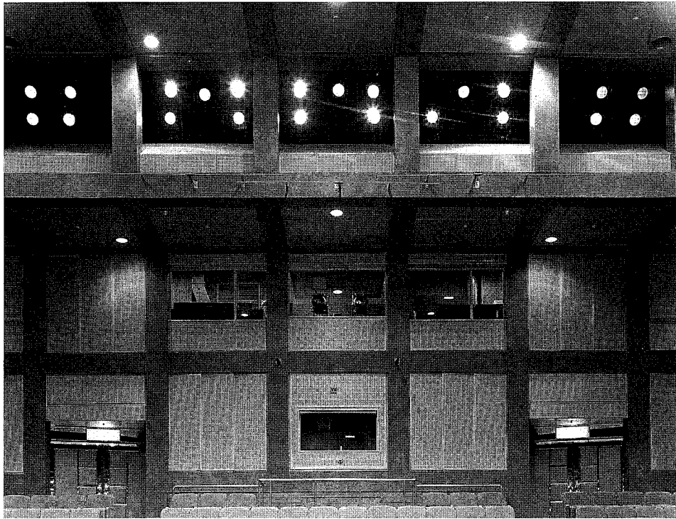
調光室とシーリングライト
