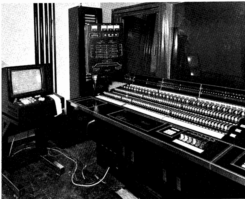
調光室 調光室には照明操作卓の他にユニクロス(自由にどこへでも移動することができます) 直調スイッチ盤(万一の事故の場合直点灯することができます)が設備されています。
