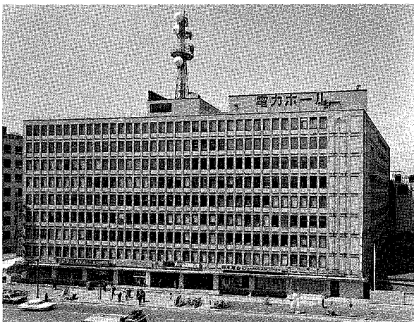
電力ホール全景
