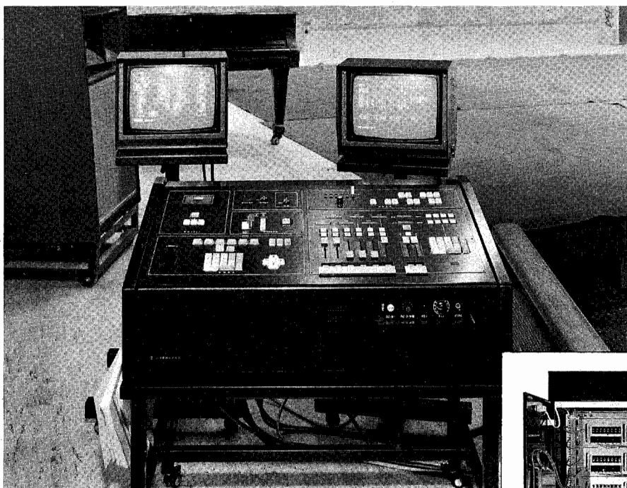
ホール舞台袖に置かれた操作卓
