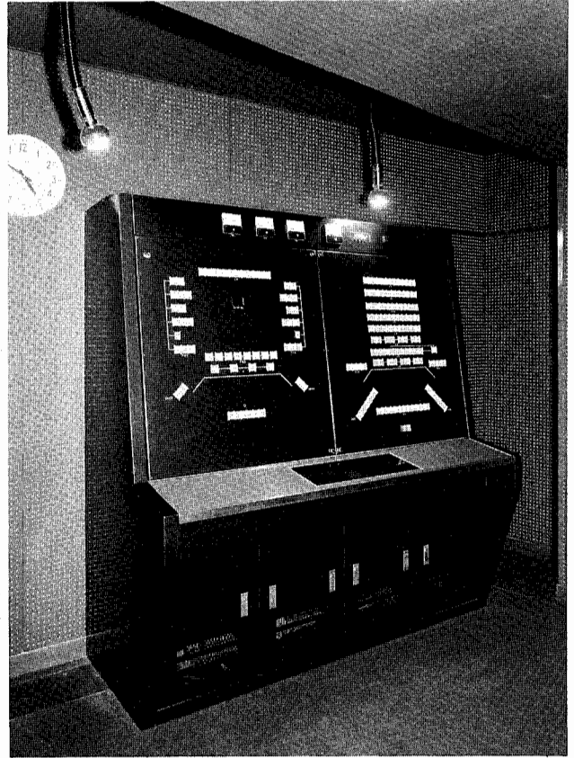
調光室の電子クロスバー選択操作盤
