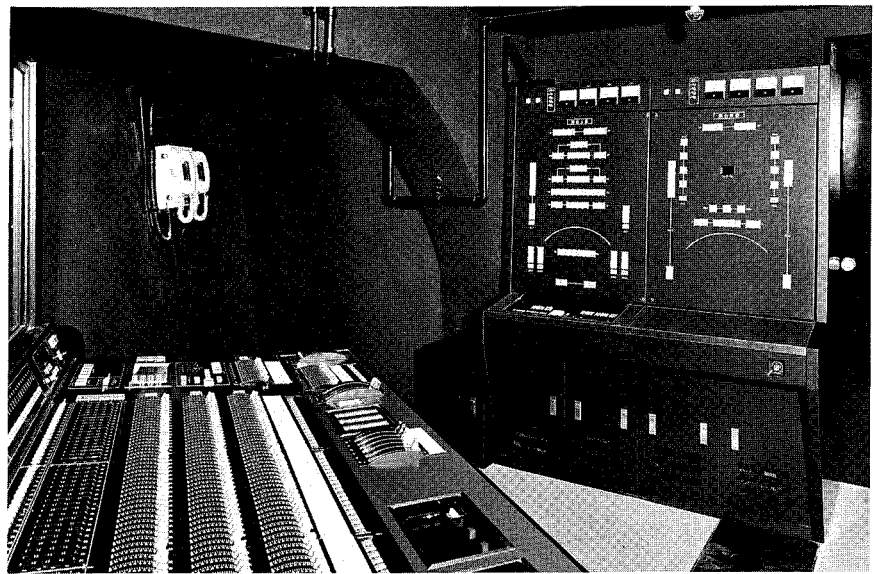
調光室の電子クロスバー選択操作盤
