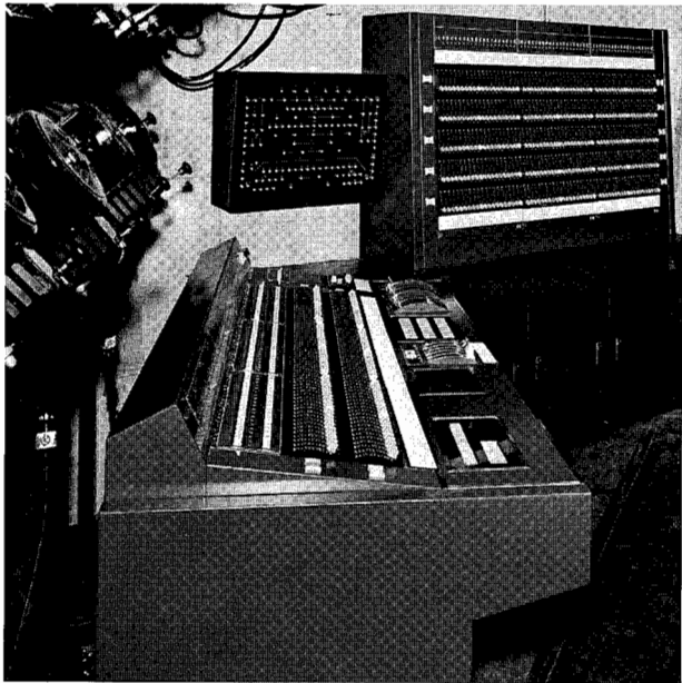
調光室の調光プリセット盤/負荷モニター盤
