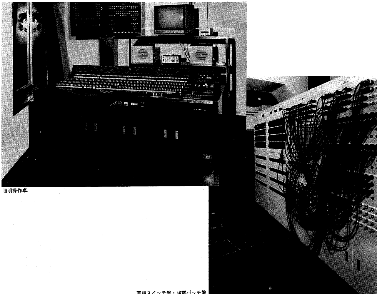
直調スイッチ盤・強電パッチ盤
