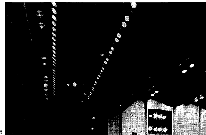
中ホール舞台上部
