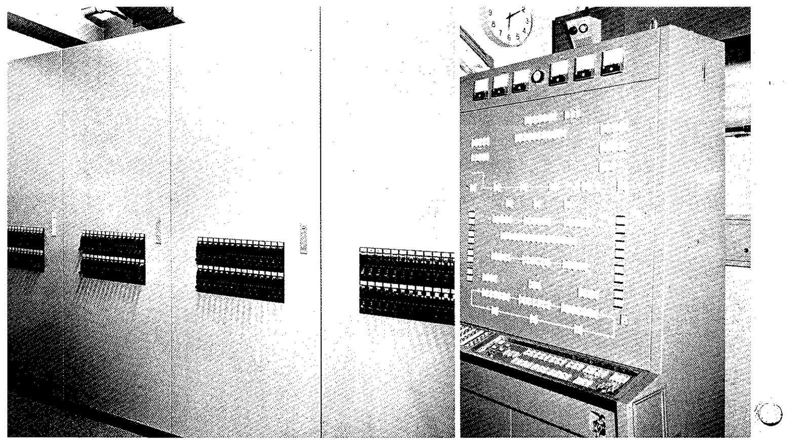
マルモが最初に開発した、コアメモリー型電子クロスバーは、照明のレベルを一躍格上げしました。高度な技術、規模の拡大がますます要求される今日、限りなく増える照明灯回線の処理は、照明家にとって大きな泣きどころでした。
