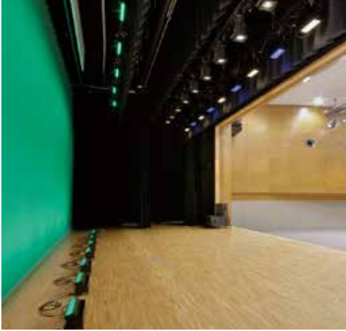
●水平ライトとして設置された LEF-3MH-3C と LEF-3MUH-3C
