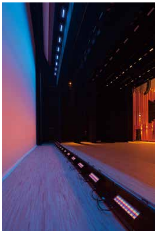
●水平トライトとして設置された LEF2-6MH-6CB と LEF-6MUH-6CB
