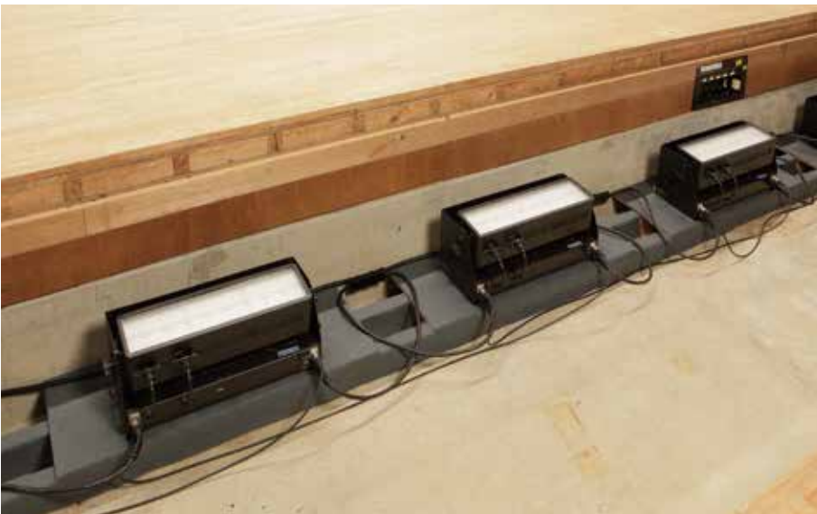
●ローア水平に設置された LEF-6MH-6CB
