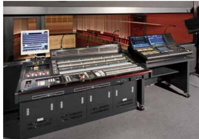
長岡リリックホール コンサートホール (据置型) Nagaoka Lyric Hall Concert Hall 新潟県長岡市 Nagaoka city, Niigata pref.
