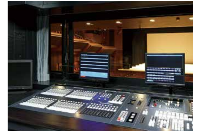
八王子市民会館 [オリンパスホール八王子] Hachioji City Hall [Olympus Hall Hachioji] 東京都八王子市 Hachioji-city, Tokyo
